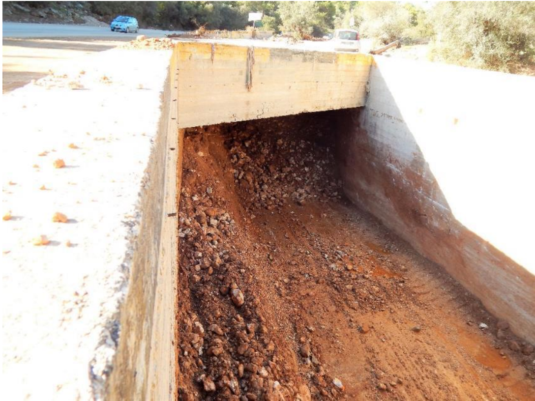
Εικ. 5.8.. Περίπτωση ολικού φραξίματος διατομών τεχνικών έργων από την πλημμύρα της Μάνδρας το Νοέμβριο του 2017. Τονίζεται ότι η μοντελοποίηση και αποτίμηση του κινδύνου εν γένει που αποτυπώνεται στην παρούσα μελέτη, βασίζεται σε υποθέσεις (όπως όλες οι μεθοδολογικές προσεγγίσεις υδραυλικής και υδρολογίας) οι οποίες είναι πιθανό κατά τη διάρκεια ενός ακραίου γεγονότος (π.χ. T=500 ) να τροποποιηθούν με δραματικό τρόπο. Στην περίπτωση του παραδείγματος της φωτογραφίας εκτιμάται ότι τα φερτά υλικά μείωσαν σε πολύ μεγάλο ποσοστό (της τάξης του 90-95%) την δυνατότητα του υδατορρέματος να παροχετεύσει νερό με αποτέλεσμα να επιδεινώσουν τις συνθήκες πλημμύρας.
