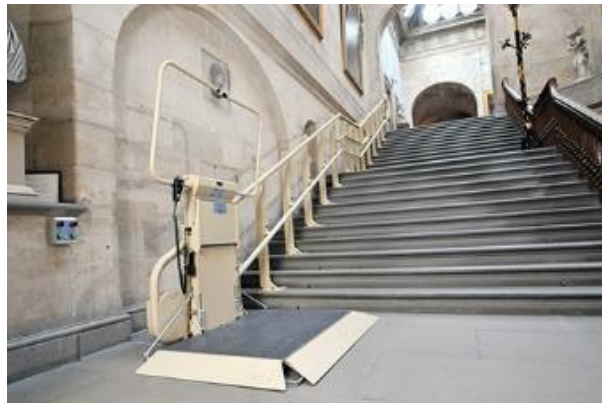
Εικόνα 227 Αναβατήριο κλίμακας με πλατφόρμα σε κτίριο Μνημείου
