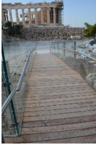
Εικόνα 196 Προσβάσιμη γέφυρα σύνδεσης του ανελκυστήρα με τον Βράχο
