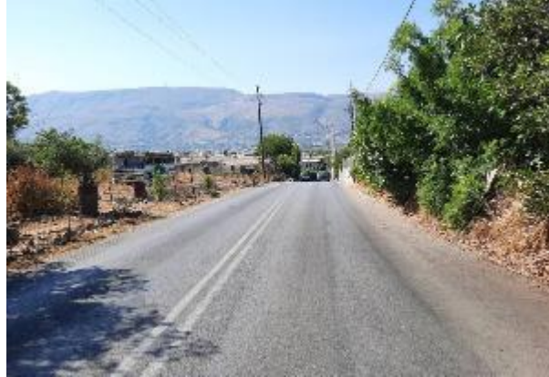
Εικόνα 161 Βασική οδός διπλής κατεύθυνσης, με κομινόμενο πλάτος 6.70-7.00 μ., χωρίς πεζοδρόμια
