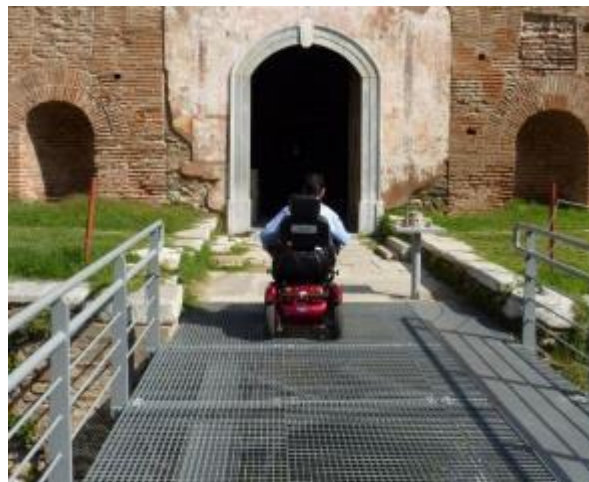
Εικόνα 217 Προσβάσιμη πεζογέφυρα σύνδεσης της Ροτόντας με το πεζοδρόμιο, περνώντας πάνω από την ανασκαφή
