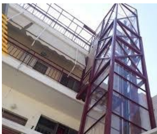
Εικόνα 82. Αναβατήριο κλειστού τύπου ή ανελκυστήρας σε αδόμητο χώρο οικοπέδου με υφιστάμενο κτίριο προς προσαρμογή
