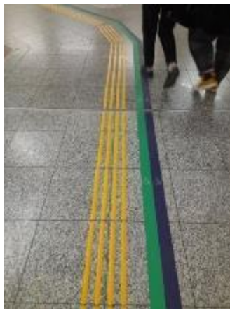
Εικόνα 212 Επίθετες ταινίες με διάταξη οδηγού στον σταθμό Μετρό Μοναστηράκι
