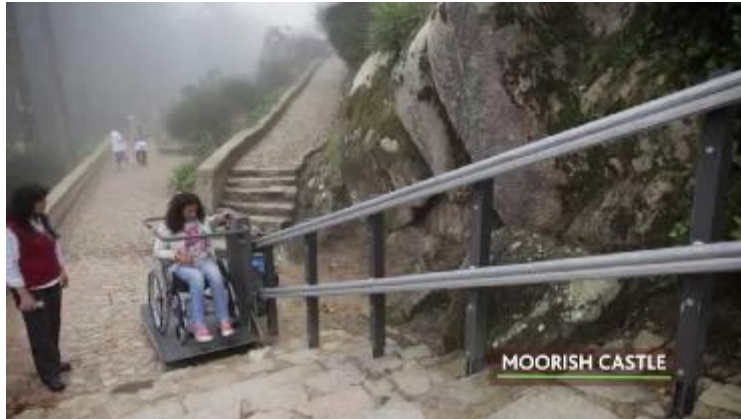
Εικόνα 215 Χρήση αναβατορίου κλίμακας με πλατφόρμα στο δασικό περιβάλλον της Sintra
