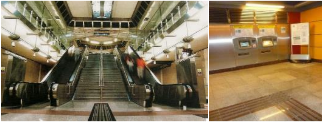
Εικόνα 116 Αστοχίες κατά την εφαρμογή του οδηγού όδευσης – αριστερά, ο οδηγός καταλήγει στον χειρολισθήρα της κλίμακας και δεξιά, δεν εξυπηρετεί σε σχέση με το μηχάνημα πώλησης εισιτηρίων
