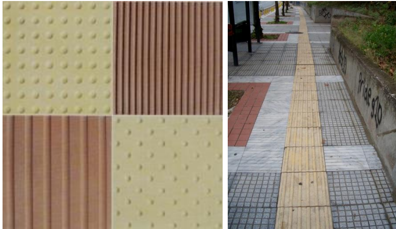
Εικόνες 114 – 115 Τα ειδικά πλακίδια του οδηγού όδευσης τυφλών βάσει της με αρ.52488/2001 Υπ. Απόφασης
