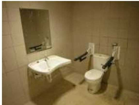
Εικόνα 69. Προσβάσιμος χώρος υγιεινής
