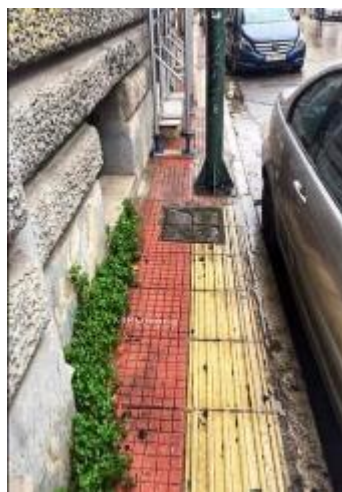
Εικόνα 116 Τοποθέτηση οδηγού όδευσης τυφλών σε στενό πεζοδρόμιο
