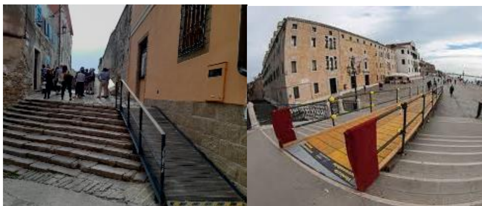
Εικόνα 209 Ράμπα από μέταλλο και ξύλο σε δρόμο με βαθμίδες στο Ιστορικό Κέντρο της Ljubljana και σε γέφυρα με πλατύσκαλα στη Βενετία
