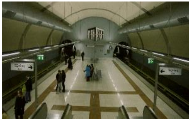
Εικόνα 115 Νέος σταθμός Μετρό («Αιγάλεω») με οδηγούς όδευσης τυφλών
