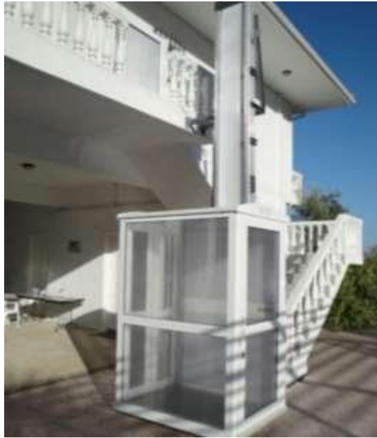
Εικόνα 37. Εξωτερικό αναβατόριο με καμπίνα για πρόσβαση στον όροφο
