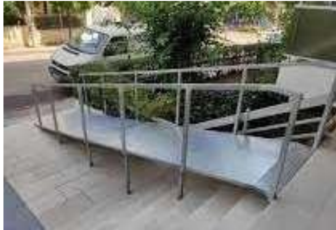
Εικόνα 22. Προσβάσιμη είσοδος κτιρίου με βαθμίδες, μέσω ράμπας
