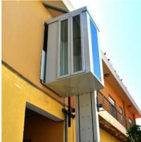
Εικόνα 83. Υφιστάμενο κτίριο προς προσαρμογή με νέα χρήση
