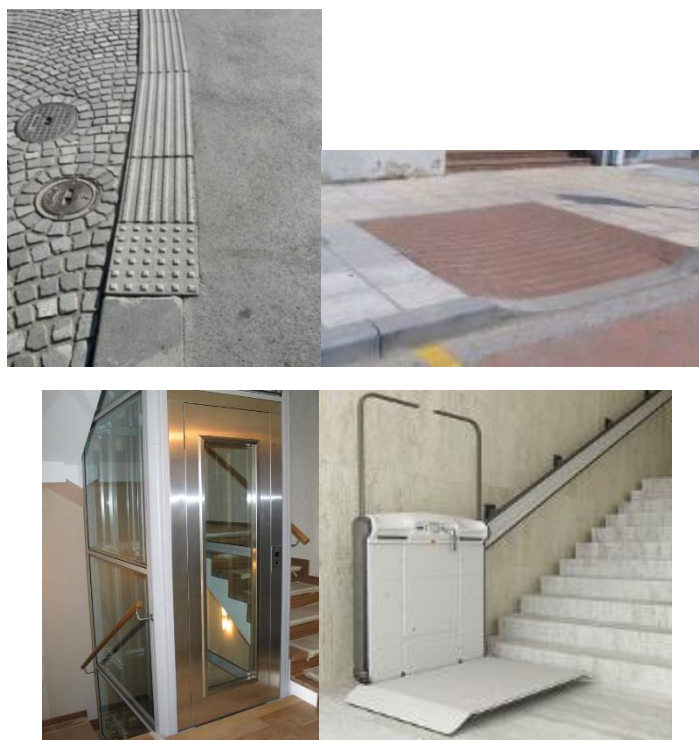
Εικόνα 184: Στοιχεία για εξασφάλιση προσβασιμότητας, οδηγός τυφλών από τυποποιημένα πλακίδια, τυποποιημένη ράμπα πεζοδρομίου, ανελκυστήρας και αναβατόριο κλίμακας
