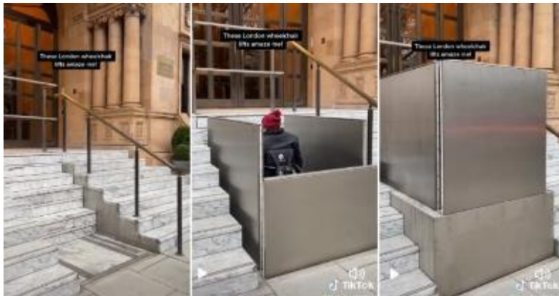
Εικόνα 36. Αναβατήριο με πλατφόρμα βυθιζόμενη στο πεζοδρόμιο, για πρόσβαση στην είσοδο
