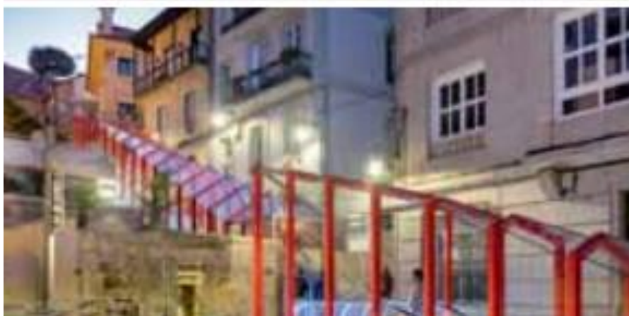
Εικόνα 147 Κυλιόμενες σκάλες που συνδέουν δύο παράλληλους δρόμους στο Βίγο της Ισπανίας
