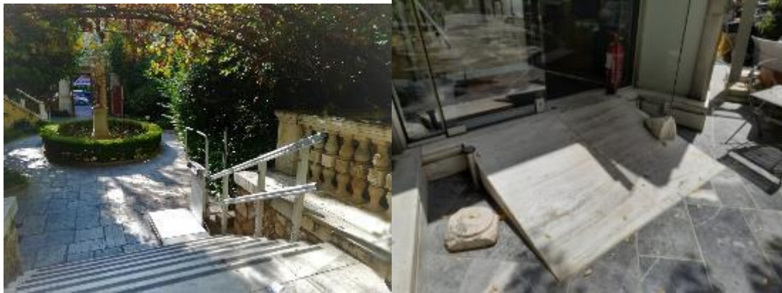
Εικόνα 224 Αναβατήριο κλίμακας με πλατφόρμα για πρόσβαση στον κήπο και στο αναψυκτήριο και μαρμάρινη ράμπα στην είσοδο του αναψυκτηρίου
