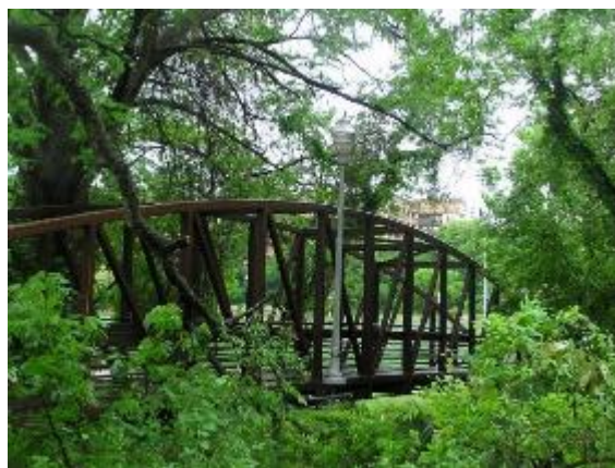
Εικόνα 106 Πεζογέφυρα σε πάρκο στον ποταμό Κολοράντο Austin TX
