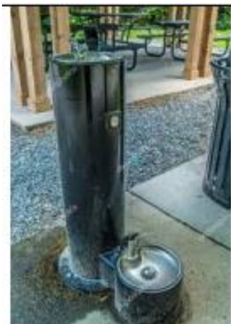
Εικόνα 143 Βρύση που είναι ειδικά σχεδιασμένη για να εξυπηρετεί και τους σκύλους οδηγούς
