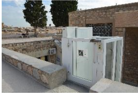
Εικόνα 197 Πρόσβαση με αναβατήριο στον προσβάσιμο χώρο υγιεινής στο παλιό κτίριο του μουσείου
