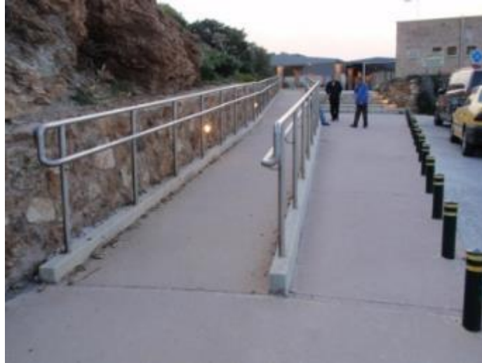
Εικόνα 200 Ράμπα από τον χώρο στάθμευσης προς το αναψυκτήριο
