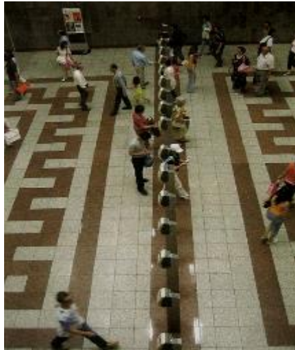
Εικόνα 114 Παλιός σταθμός Μετρό («Σύνταγμα») χωρίς οδηγούς όδευσης τυφλών
