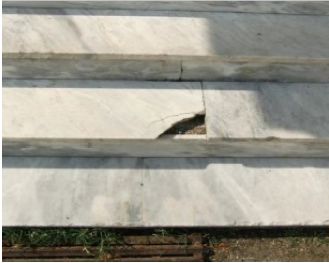
Εικόνα 26. Φθορές σε εξωτερικές σκάλες, οι οποίες αποτελούν κίνδυνο για πτώση (πηγή: https://agogi.weebly.com/uploads/1/4/6/5/14657488/002.pdf )
